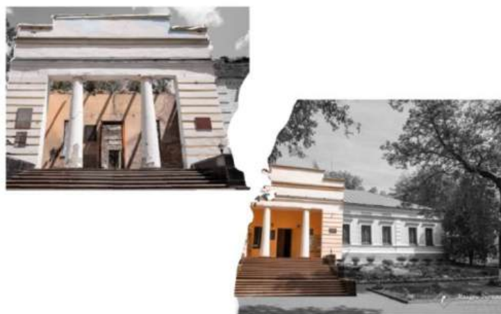
Рис. 1. Фото-порівняння руйнації головного входу до музею (нижнє фото до, верхнє-після)
