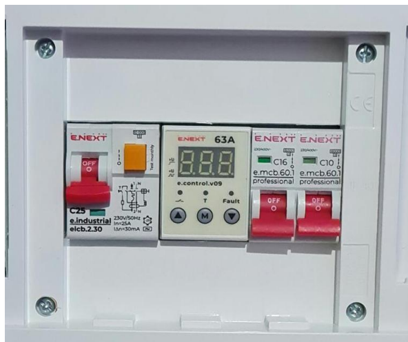
Рис. 9.1. Розподільчий щит для однокімнатної квартири
